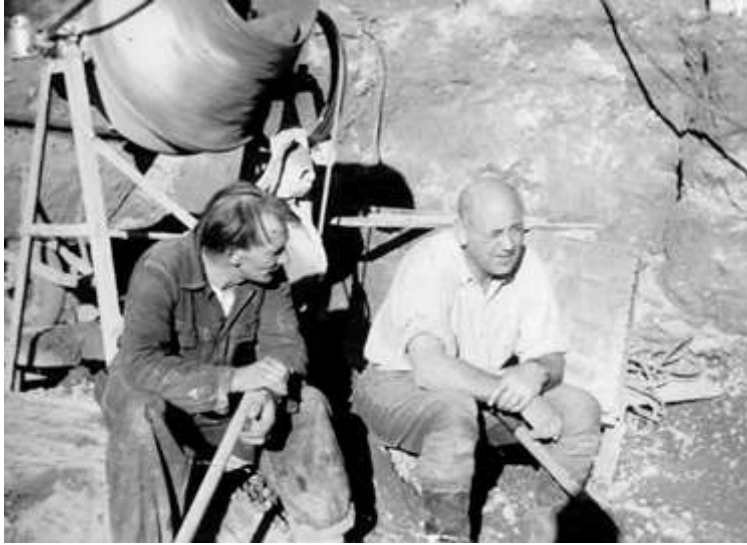
Fra arbeidet på tomta til Nesje. " Taklarsen" til venstre og Nesje til høyre. Det var to Larsen på Reistad. Den ene var taktekker, derfor "Taklarsen".
